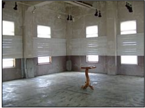
(3階に入って左(奥)を見る 床も注目)
